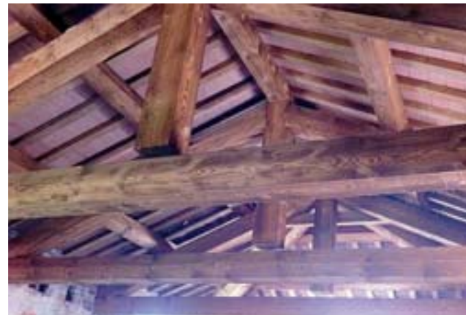
La copertura ora è stata restaurata e messa in sicurezza
