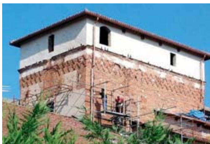
Si lavora alla parete Est della Torre di Frugarolo
