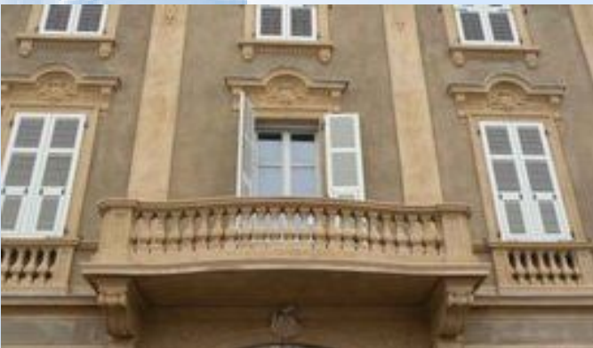
Fig.10 Particolare del balcone sul cortile interno dopo il restauro
