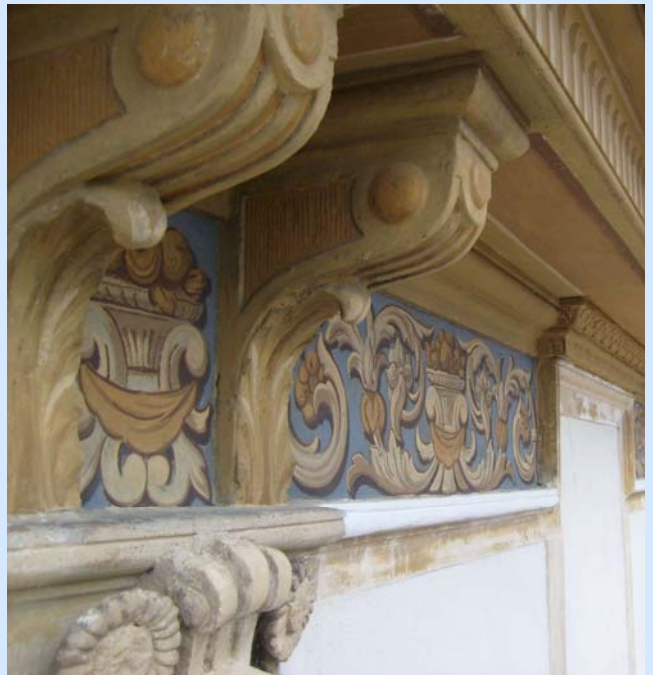
Fig.7 Particolare del fregio dipinto posto sotto il cornicione
