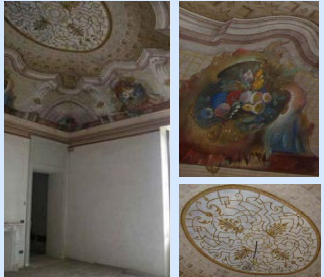
Fig.12,13,14 Particolari nelle volte del piano nobile
