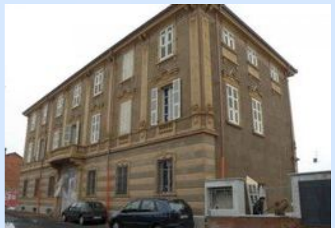
Fig.1 Veduta d'insieme del prospetto su via Villanova
