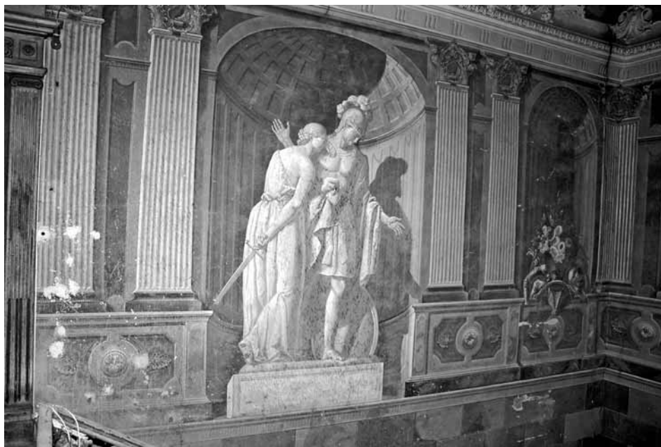
Fig. 9. Particolare della decorazione figurativa che caratterizza le pareti dello scalone di rappresentanza.
